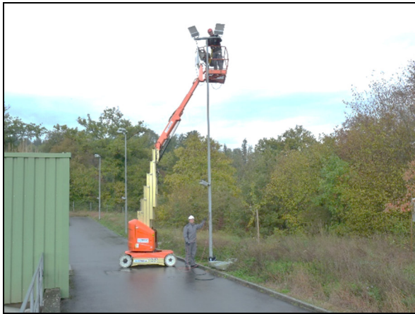
Alte Arealbeleuchtung aus dem Jahr 2009 mit modernen hocheffizienten LED Leuchten ersetzen, 23. - 25. Oktober 2023
